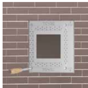
Fixer la boîte d'encastrement aux 4 coins
